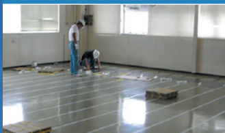
1 割付図に合わせて両面テープを貼る
