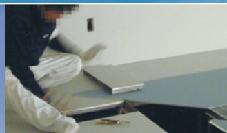
4 カバープレートを設置して完成
