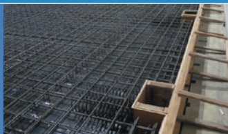
2 型枠・配筋の施工
