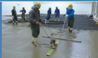
3 コンクリート層の打設
