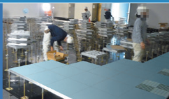
2 OAフロアの施工
