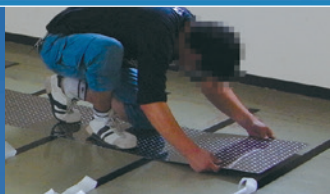
2 セルシートの敷設
