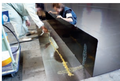
防水・防塵用グリスの注入
