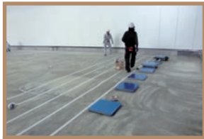
1 専用両面テープ施工
