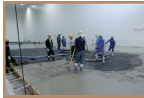
3 コンクリート打設
