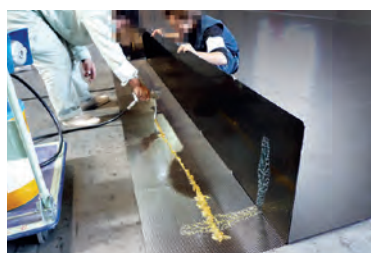
防水・防塵用グリスの注入
