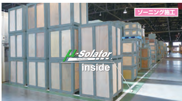
補給品倉庫内積載ゾーン
