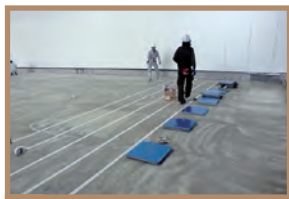
1 専用両面テープ施工
