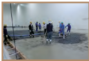
3 コンクリート打設
